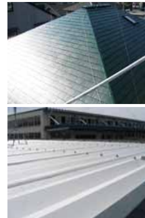
一軒家・工場屋根施工
